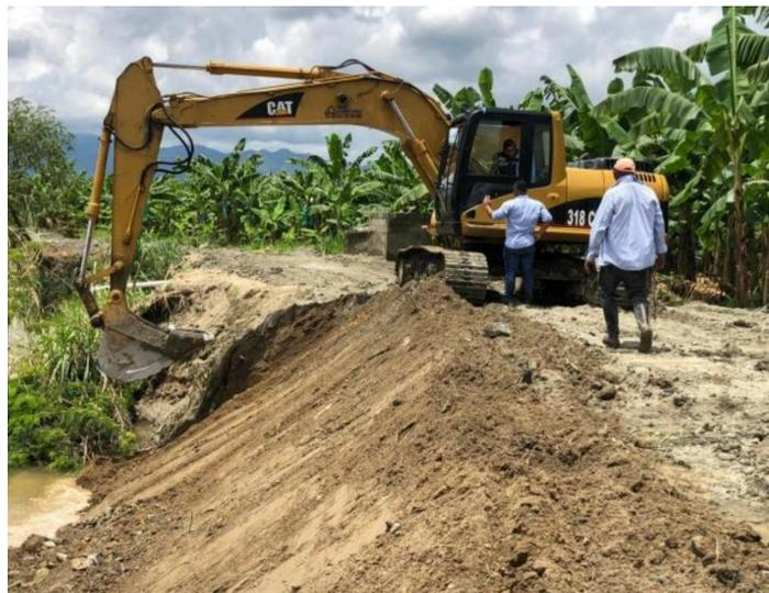
Imagen 6 | Construcción de la margen izquierda del Río Sevilla
