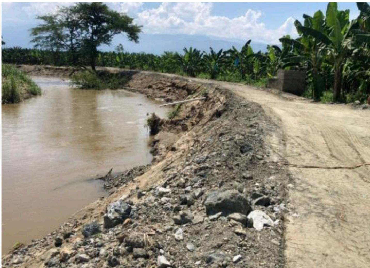
Imagen 7 | Conformación del talud del Río Sevilla
